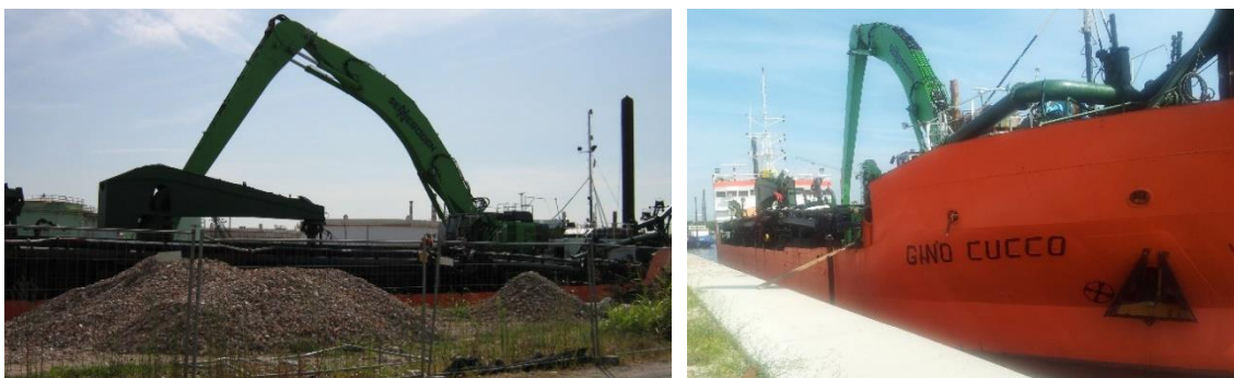
Una visione della maestosità dell'escavatore
