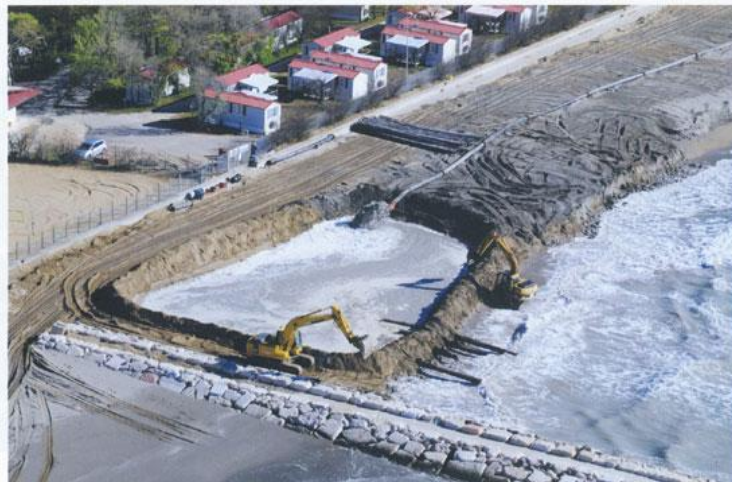
Refluento a terra mediante condotta con diffusore
