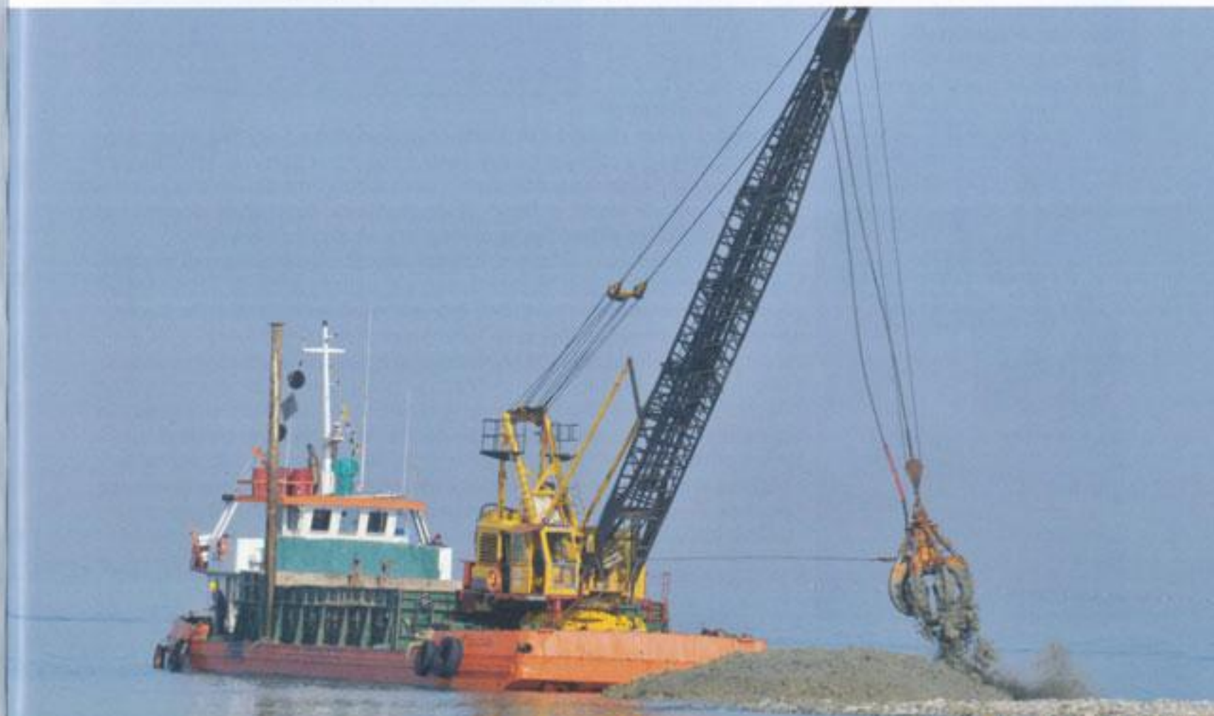
M/N Pontone "Dragonda" Escavo darsena Cattolica
